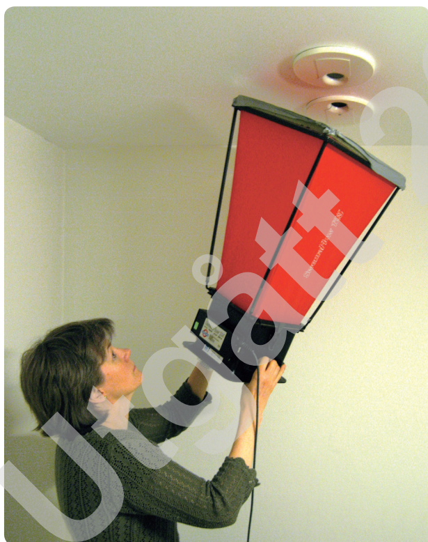
Fig. 233 Eksempel på måling av avtrekksluft gjennom ventil i våtrom i mindre bygning ved bruk av spesialutstyr. Foto: SINTEF Byggforsk
